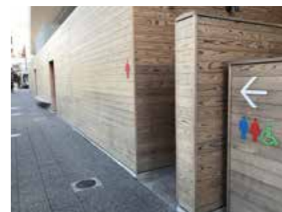
●外構多目的トイレ
