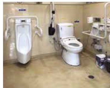
●毎日屋大橋通店 多目的トイレ (店内)
