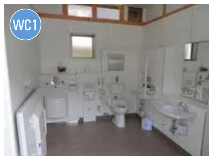
●高知城駐車場 多目的トイレ
