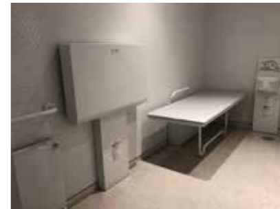
●1階多目的トイレ(介護用簡易ベット有)
